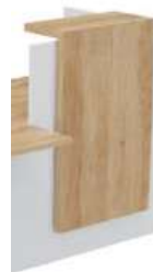
Parement installé sans entretoise
